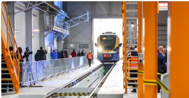
Budowa i wyposażenie zaplecza technicznego do obsługi taboru kolejowego
